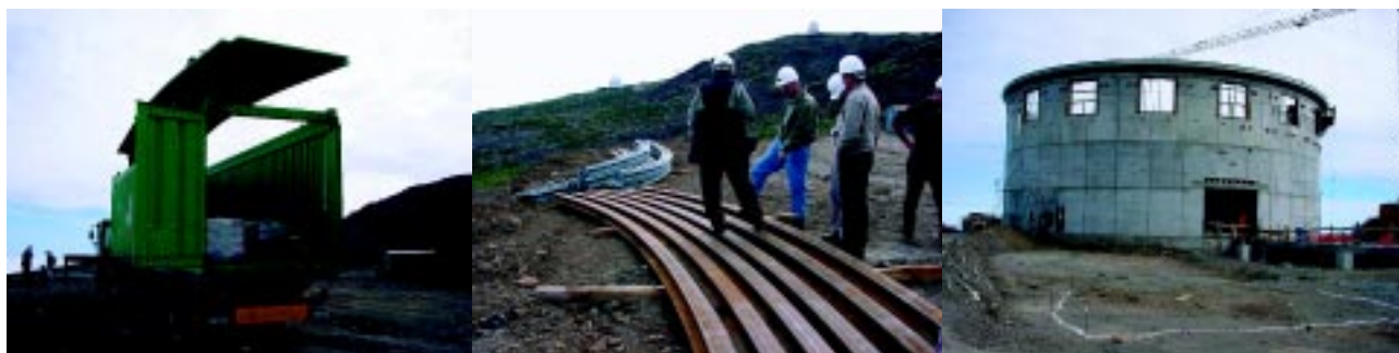
Imágenes de la llegada al Observatorio del Roque de los Muchachos, en La Palma, de los contenedores con piezas de la cúpula del GTC.
