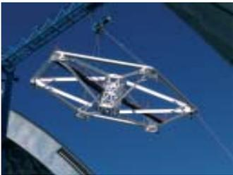
*De arriba abajo: tubo antes de la instalación de la araña; introducción de la araña del secundario del GTC a través de la compuerta de observación; y grúa transportando la araña del GTC.
