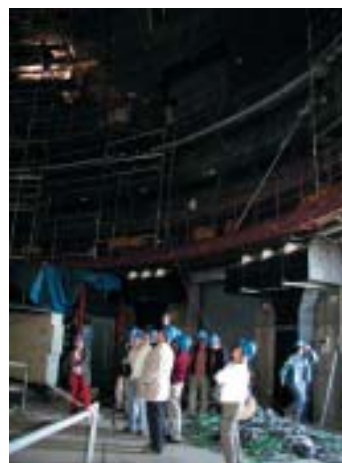
El grupo de representantes de ESO durante su estancia en el ORM visitando las obras del GTC.
