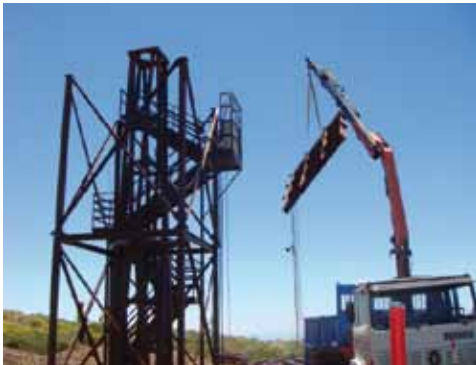
Arriba: Etapa inicial del desmontaje de la torreta de 10 m, ubicada en las inmediaciones del telescopio MAGIC en el ORM.
