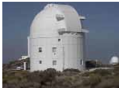
Nueva ventana (0°-40°) de la cúpula del telescopio OGS, que permite maximizar el tiempo de los enlaces ópticos con satélites en órbita baja.
