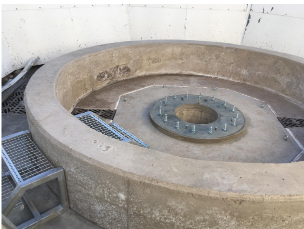
Cimiento del TMS.
